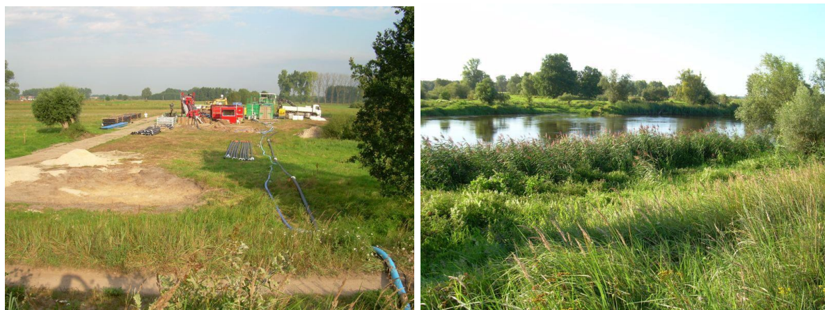
Fot. Przekroczenie rzeki Warty i terenów chronionych w rejonie Gorzowa Wielkopolskiego. Długość otworu 1001 m. (Fot. Nawitel)
