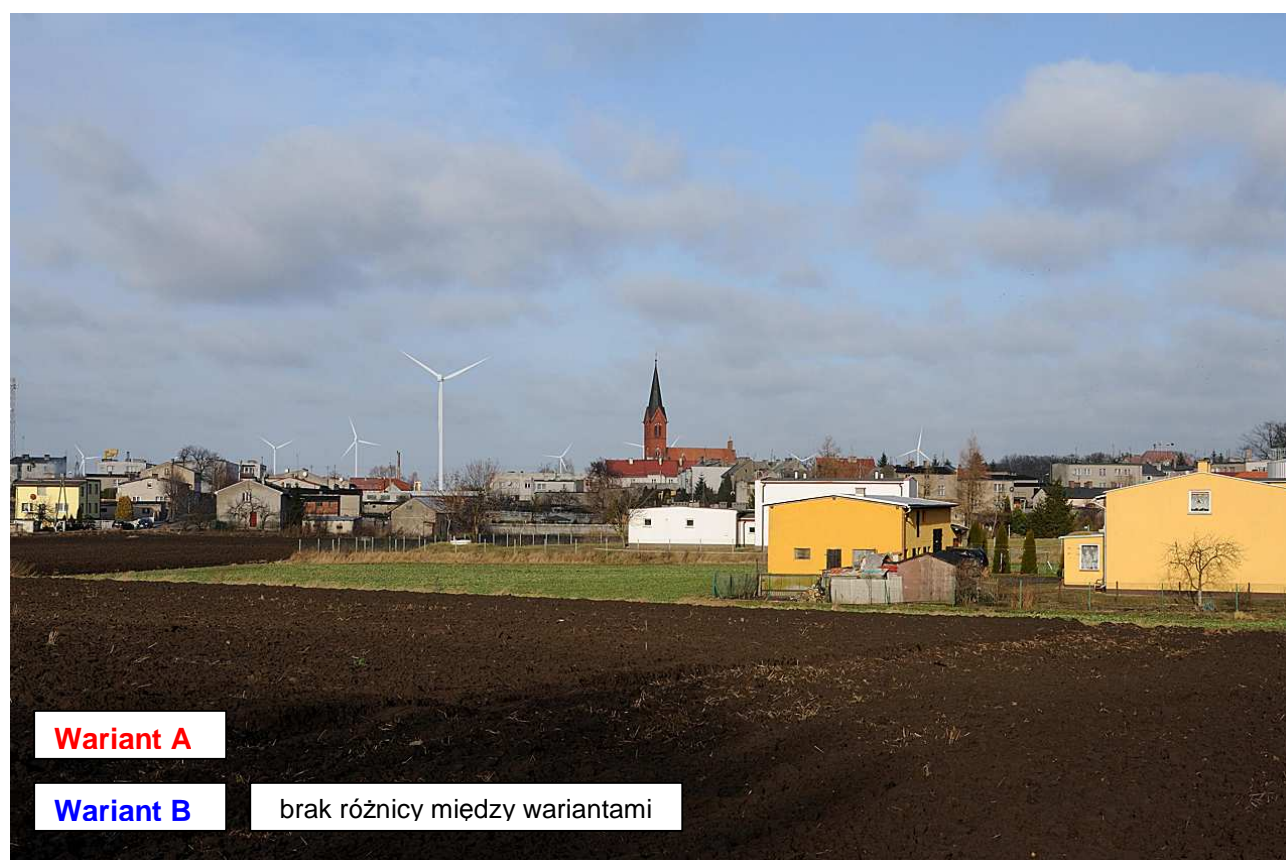
Ryc. 54. Widok na Biskupiec w kierunku osi widokowej nr 2. Odległość do najbliższej turbiny T23- 1800 m.
