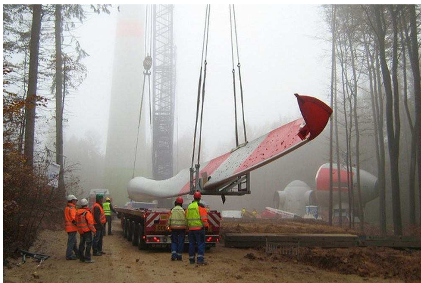
Ryc. 14. Manewrowanie dowiezionym skrzydłem wirnika (przykład innej inwestycji)
