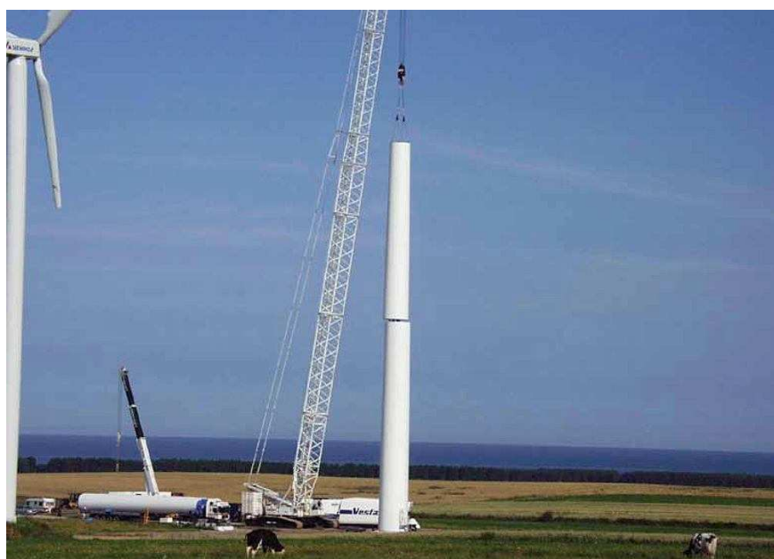
Ryc. 15. Montaż wieży silowni (przykład innej inwestycji). Praca żurawia instalującego elementy, wraz z żurawiem pomocniczym [źródło: www.energiaeco.pl/zbudowy.html ]
